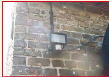
Illustration 32 : le libre accès aux carburants peut faciliter l'incendie volontaire (à gauche) tandis qu'un éclairage avec détecteur de mouvement signalera l'accès par des étrangers (à droite)
