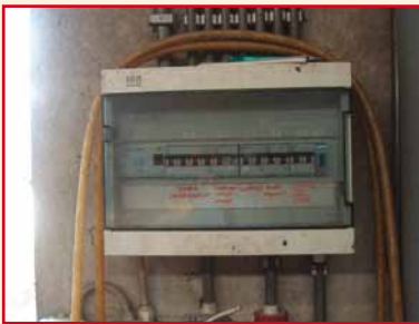
Illustration 21 : la désignation de fusibles (à gauche) avec un commutateur différentiel (à droite)
