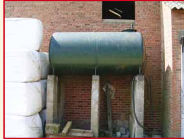
Illustration 31 : présence de matériaux inflammables à proximité d'un brûleur (à gauche) et entreposage de bottes de foin à sécher à côté d'un réservoir de mazout non contrôlé (à droite)
