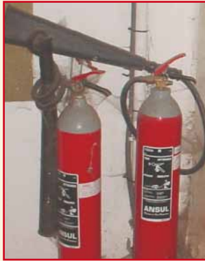
Illustration 58 : un extincteur à gaz carbonique à la bouche d'aspersion spécifique
