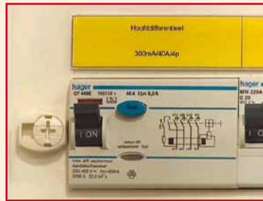
Illustration 21 : la désignation de fusibles (à gauche) avec un commutateur différentiel (à droite)
