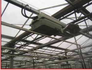
Illustration 30 : lampes d'assimilation (à gauche) et toiles (à droite) : une combinaison risquée
