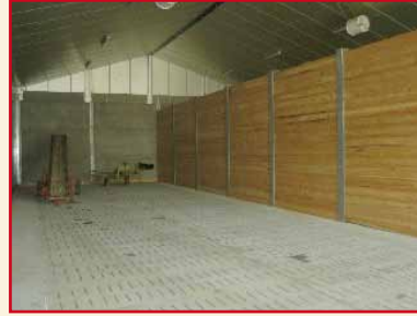
Illustration 29 : ventilateur avec câbles lâches pour l'alimentation, la commande et les détecteurs (à gauche), caillebotis et compartimentage en bois et isolation de la chambre de compression (à droite)
