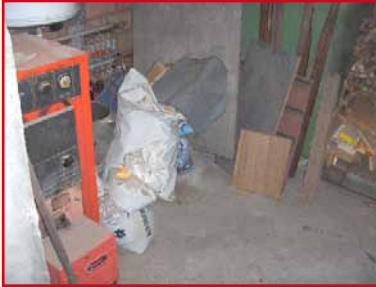
Illustration 31 : présence de matériaux inflammables à proximité d'un brûleur (à gauche) et entreposage de bottes de foin à sécher à côté d'un réservoir de mazout non contrôlé (à droite)
