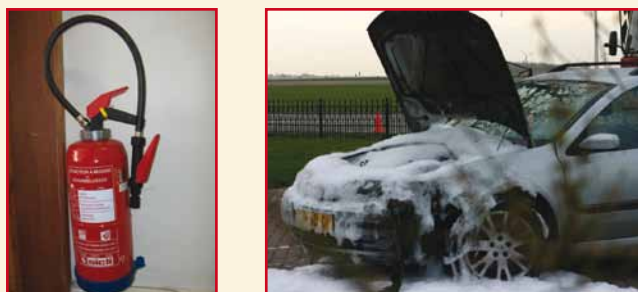
Illustration 56 : un extincteur à mousse au mur (à gauche) et en action (à droite)
