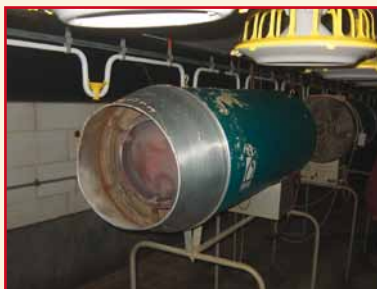
Illustration 25 : un poêle à gaz (à gauche) comme une soufflerie d'air chaud présentent des risques d'incendie
