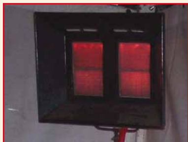
Illustration 25 : un poêle à gaz (à gauche) comme une soufflerie d'air chaud présentent des risques d'incendie
