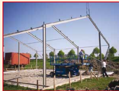
Illustration 10 : chariot de transport en aluminium (à gauche) et construction en acier d'un hangar (à droite)
