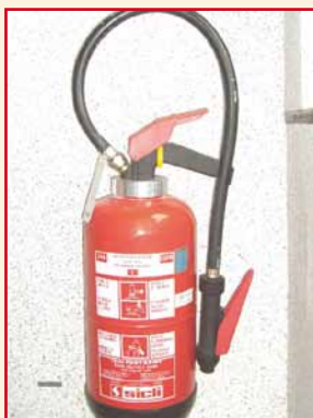
Illustration 54 : un petit extincteur à poudre (1 kg) suspendu dans un chargeur frontal, un extincteur à poudre plus grand suspendu au mur
