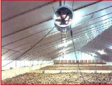
Illustration 29 : ventilateur avec câbles lâches pour l'alimentation, la commande et les détecteurs (à gauche), caillebotis et compartimentage en bois et isolation de la chambre de compression (à droite)
