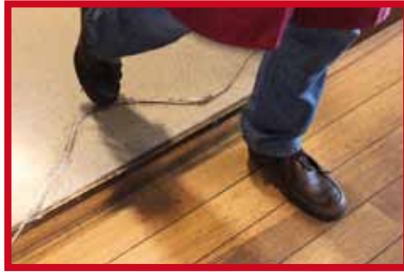
Losliggende kabels en draden vormen een struikelgevaar
