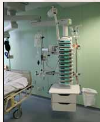
Zuil in een afdeling intensieve zorgen, opgehangen aan het plafond : de vloer is vrij van bedrading of karretjes op wielen allerhande, ...
