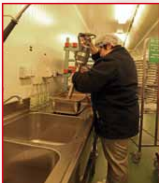
Bassin te hoog geplaatst voor het gebruik van een mixer in een keuken
